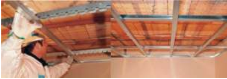
Foto 3 – Installazione di struttura di sostegno ancorata alle pareti perimetrali.
